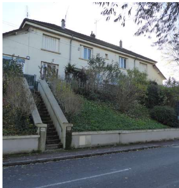
Escaliers et talus nord-ouest.
