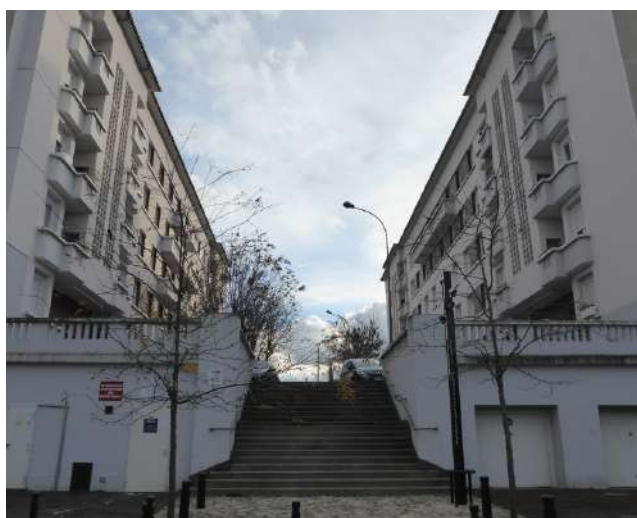
Escalier d'accès aux immeubles.
