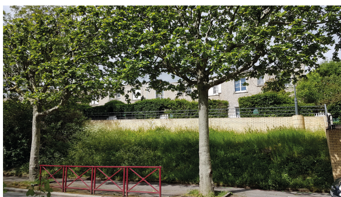
12 - Les remblais sur l'avenue Edouard Vaillant mettent les pavillons à distance de l'espace public.
