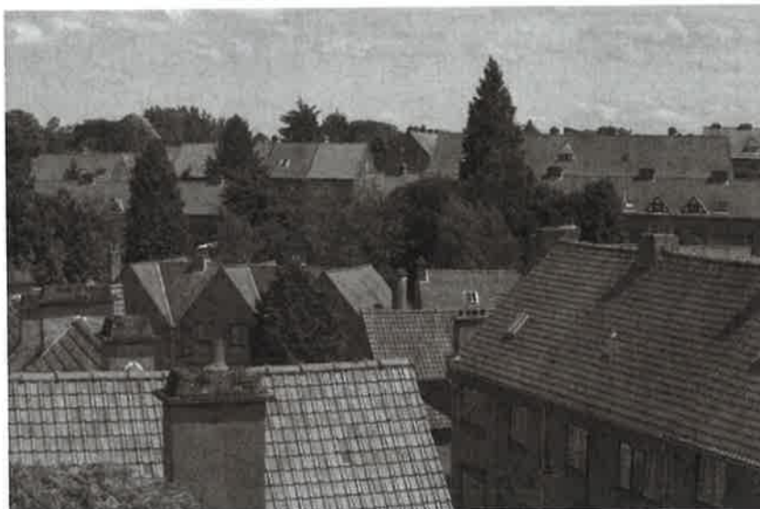
Certains logements sociaux du Logis et du Floréal, cités-jardins classées de Watermael-Boitsfort, sont inoccupés en raison de leur dégradation. Reporters / POLET
