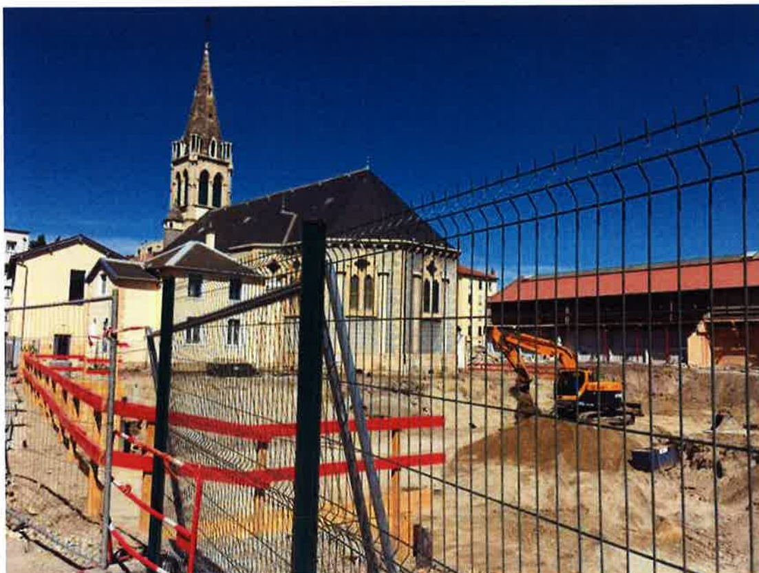
L'église Notre-Dame-des-Anges, encerclée par les travaux. Adrien Naselli
