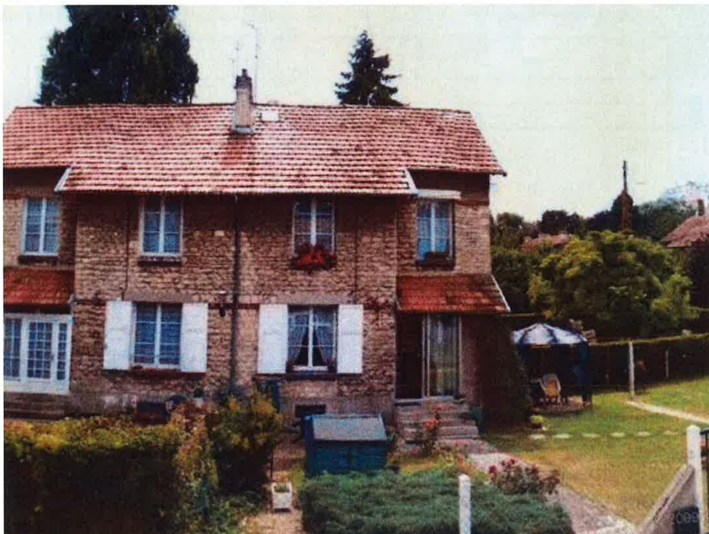
La maison qu'occupait Colette Lecomte est une des premières habitations à bon marché, construite en 1930. | ARCHIVES OUEST-FRANCE
