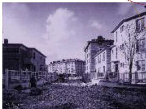
La Cité-jardins en construction, 1932
